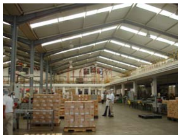
Figura 56. Nave 1 área de llenaje
