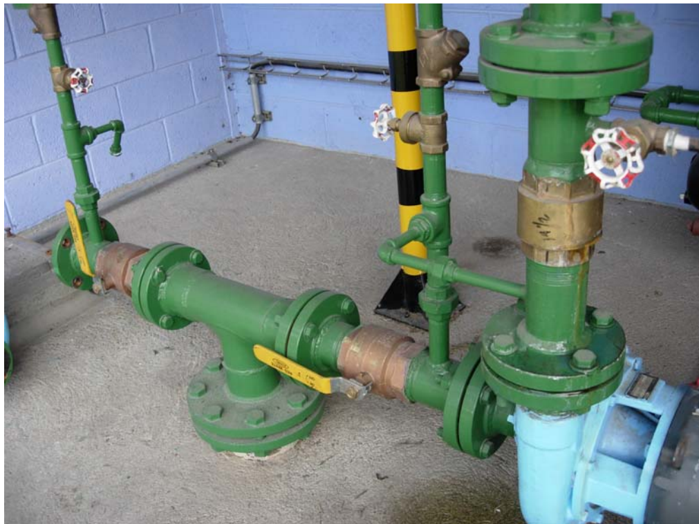
Figura 29. Pozo de servicios generales
