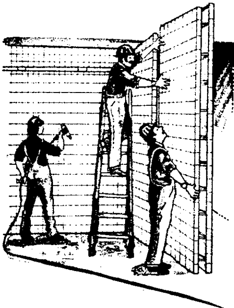
Figura 4. Instalación de Panel en Muros.
