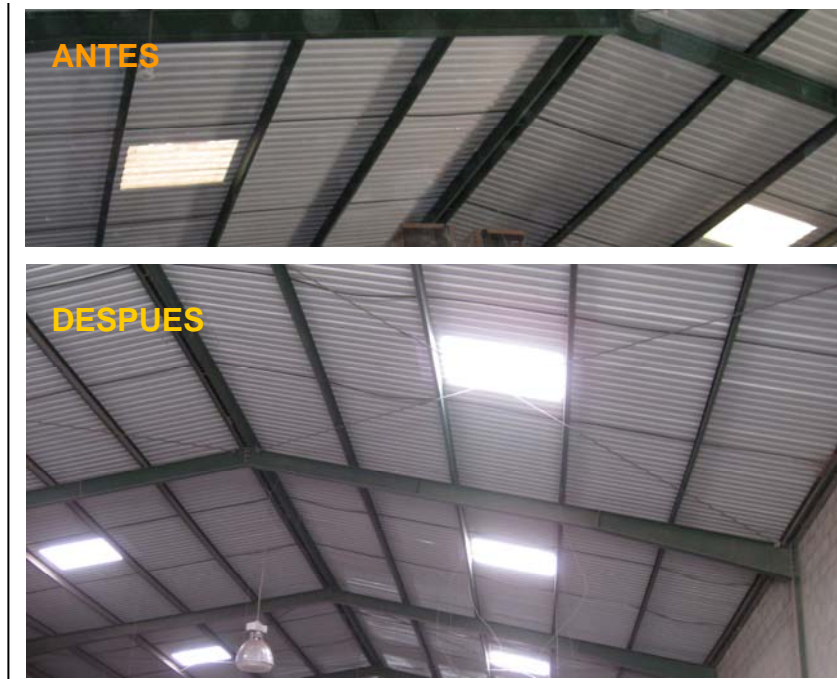
Figura 16. Techo de bodegas antes y después de cambio de lámina transparente
