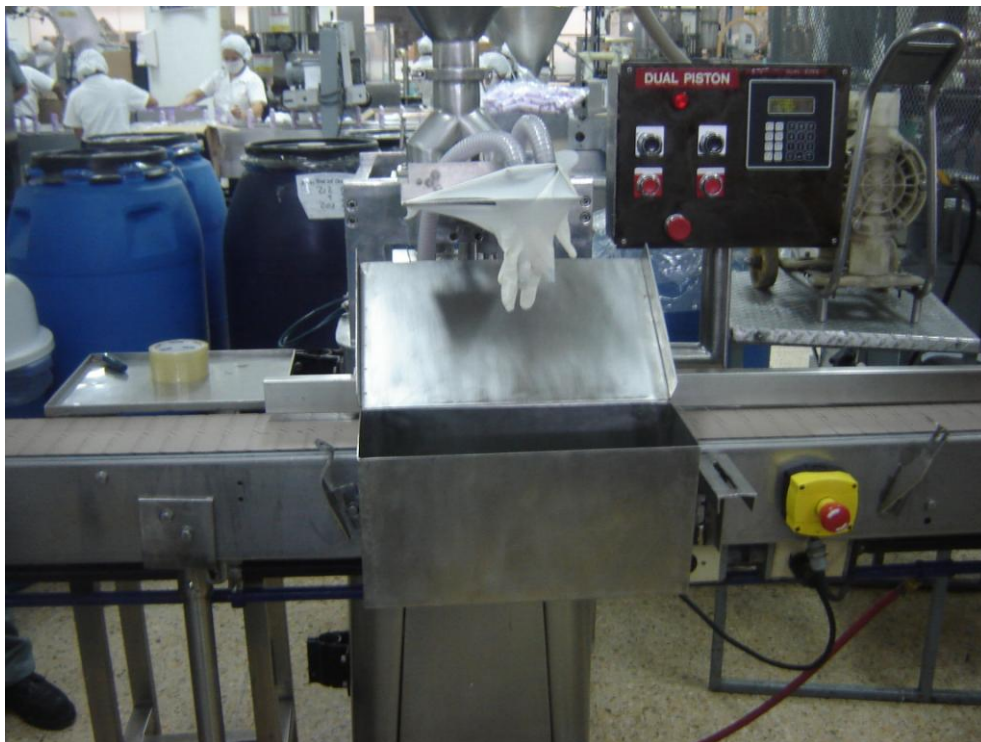
Figura 24. Bandeja para llenadora Dual instalada
