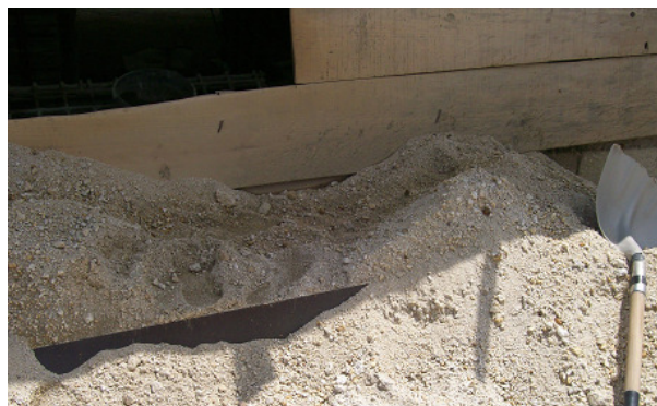
Figura 11 Descarga de arena en fábrica
