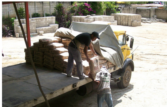
Figura 10. Descarga de cemento en fábrica y selecto hacia bodega
