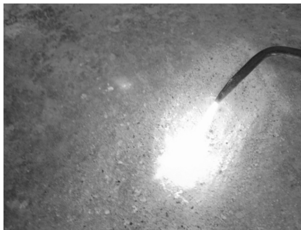
Figura 27. Proceso de expansión con soldadora de acetileno
