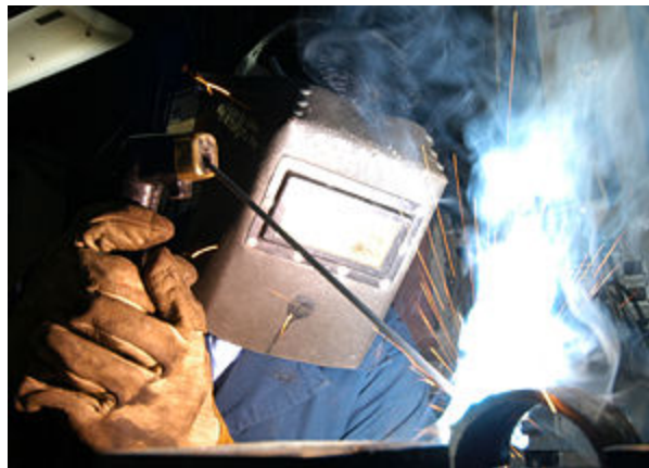
Figura 11: Soldadura de metal por arco.
