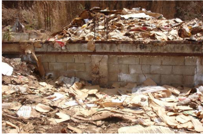
Figura 36. Estado actual área de rampa de carga y descarga.
