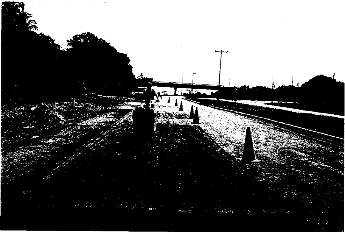
En esta fotografía se observa la indumentaria utilizada por el personal de ejecución y conos de protección en un tramo pavimentado.
