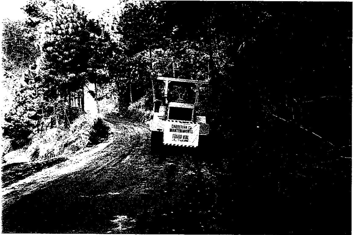
En está fotografía se observa la utilización de dispositivos de seguridad en un tramo No Pavimentado, tales como señales informativas ( manta en maquinaria ).
