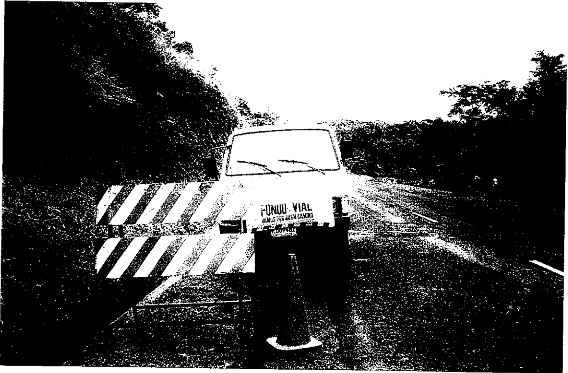
En esta fotografía se observa la utilización de dispositivos de seguridad en un Proyecto de Limpieza del Derecho de Vía, tal como esta Señal Preventiva. Así mismo una Señal Informativa ( manta en camión ).
