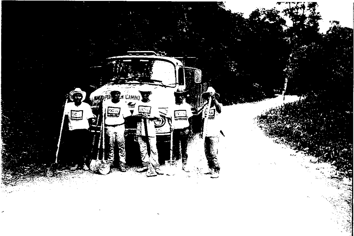
En esta fotografía se observa una Señal Informativa ( manta en maquinaria ) y personal con indumentaria apropiada en un tramo No Pavimentado.
