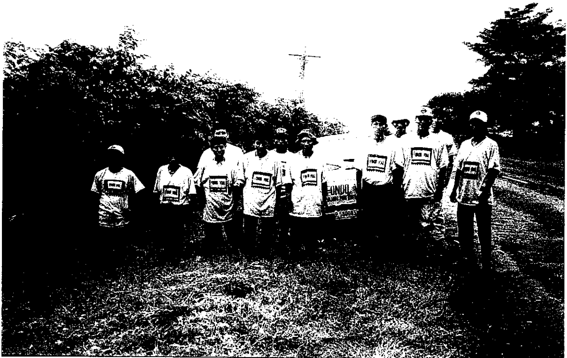
En esta fotografía se observa personal en un Proyecto de Limpieza del Derecho de Vía utilizando la indumentaria apropiada, así como una señal del tipo Informativa ( manta en vehículo ).
