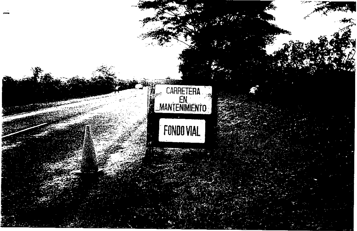
En esta fotografía se observa la utilización de dispositivos de seguridad en un Proyecto de Limpieza del Derecho de Vía, tal como esta señal informativa. Así mismo personal utilizando la indumentaria apropiada.
