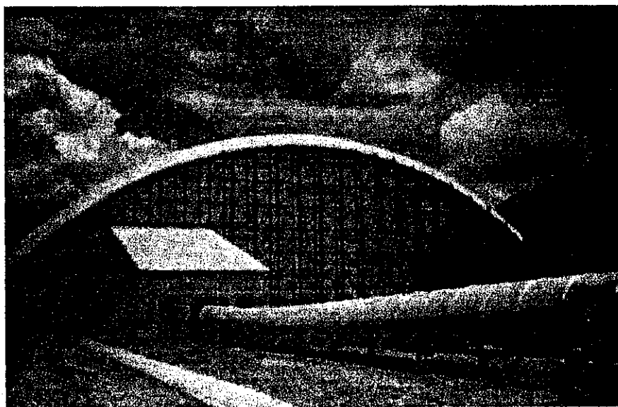
Fig. 4.4 Luego de la limpiar la estructura de desperdicios y obras falsas se procede a la entrega final de la misma.
