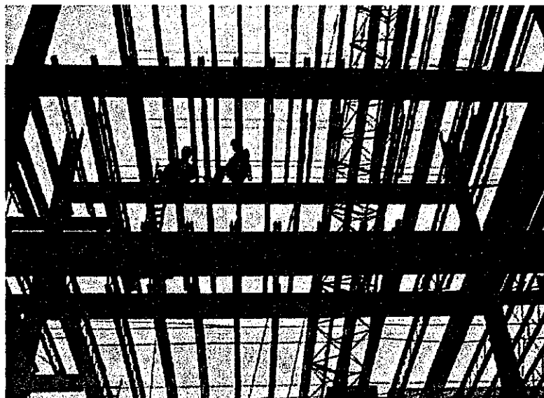
Fig. 4.2 En el caso de estructuras con tornillo de alta resistencia, las cuadrillas de atornillado con frecuencia realizan las labores de ajuste como parte de su trabajo normal.
