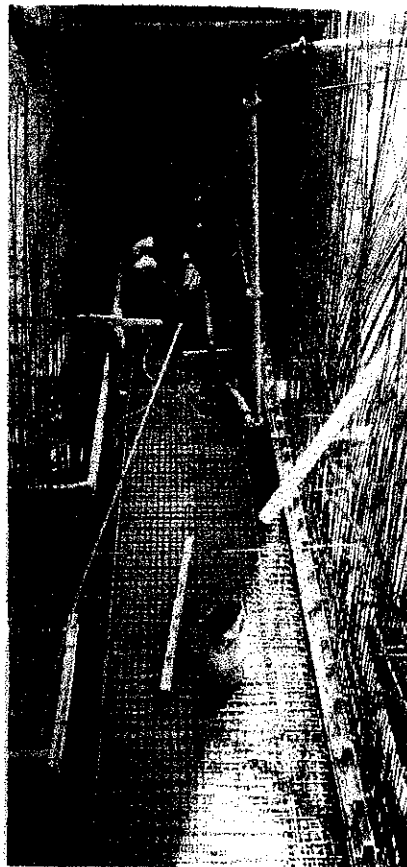
Fig. 5. Cuando se realizan fundiciones con bomba es pertinente que la disposición de la colocación de la línea de tubería sea supervisada, para no tener contratiempos en la colocación del concreto que pueden crear problemas; además debe mantenerse comunicación directa entre el operador de la bomba y la cuadrilla de colocación. Es también aconsejable revisar los soportes del acero de refuerzo para evitar que éste pueda perder su ubicación.
