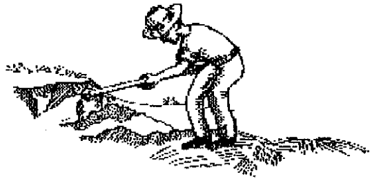
Figura No. 3. Batido del barro para fabricar adobe.
