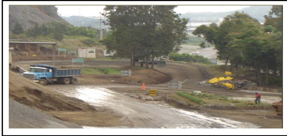
Figura 17. Área de señalizaciones y protección de seguridad
