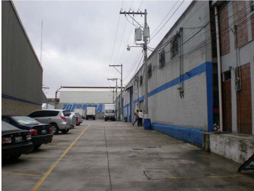
Figura 3. Vista exterior de las bodegas 1 a la 5.
