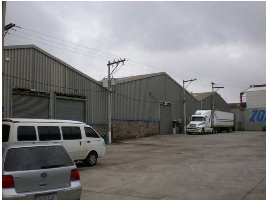
Figura 4. Vista exterior de las bodegas 6 a la 8.
