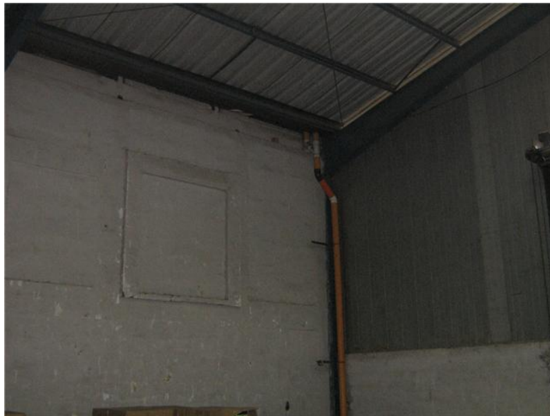
Figura 2. Vista interior de una bodega con cubierta de lámina troquelada y pared de block.
