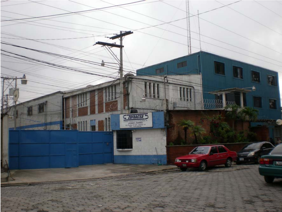
Figura 1. Vista frontal de las instalaciones.
