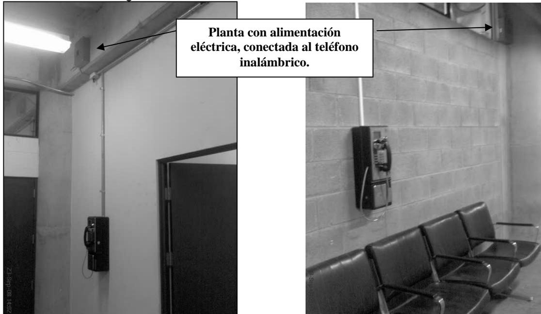
Otros aparatos utilizan conexión eléctrica además de batería, al interrumpirse la electricidad, la batería tiene una duración de aproximadamente tres horas en espera o de noventa minutos en conversación.
