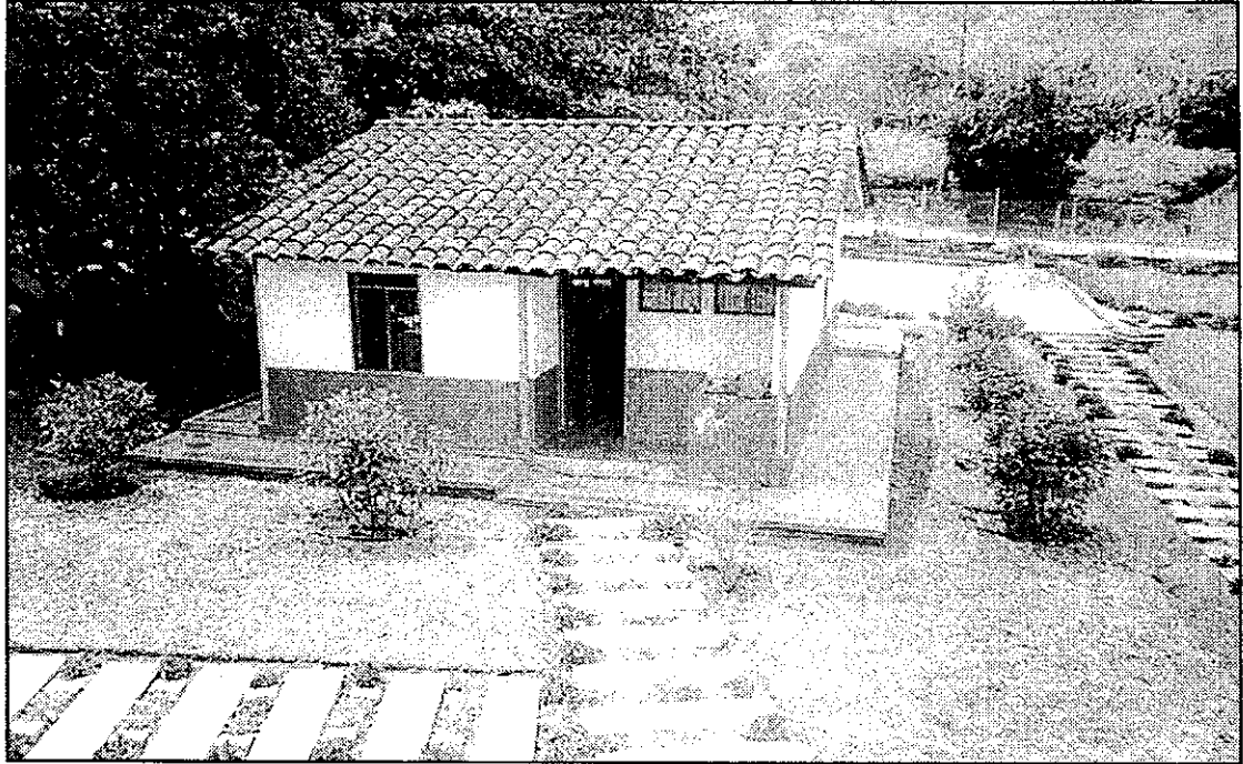
Vivienda modelo de la Corporación Autónoma Regional del Quindío, CRQ, estructura de bambú, cerramiento de tableros de esterilla en ambas caras de la estructura y mortero de revestimiento.
