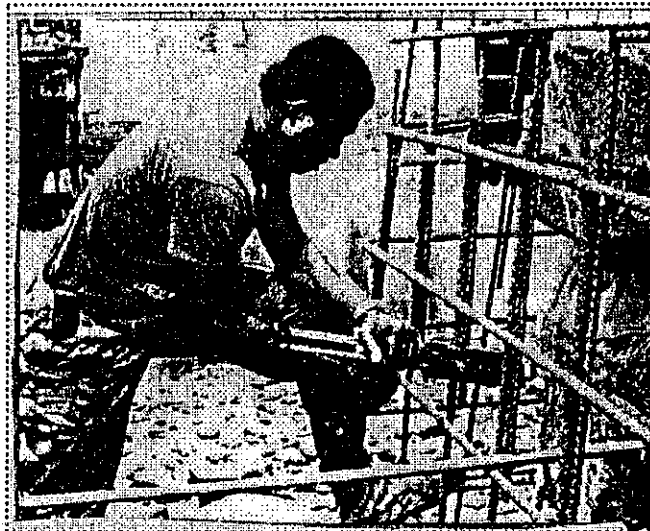
Figura 2,4. Instalación de pines para estructuras de concreto.
