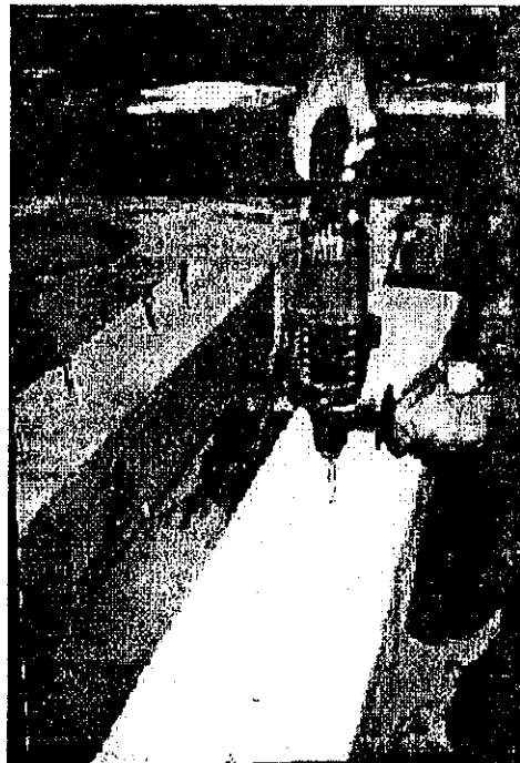
Foto 4. Forma de colocar el rotomartillo.
