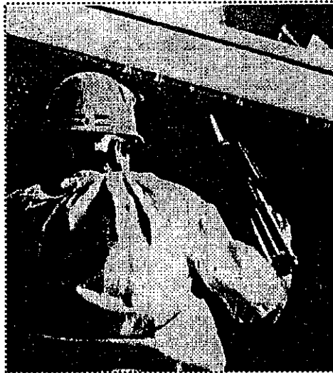
Figura 2.7. Forma como se está aplicando el ceramic 6 hacia arriba.
