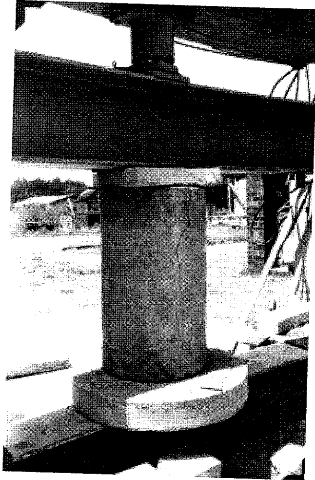
FOTO 9: Muestra la falla en la parte de atrás de la candela domiciliar.
