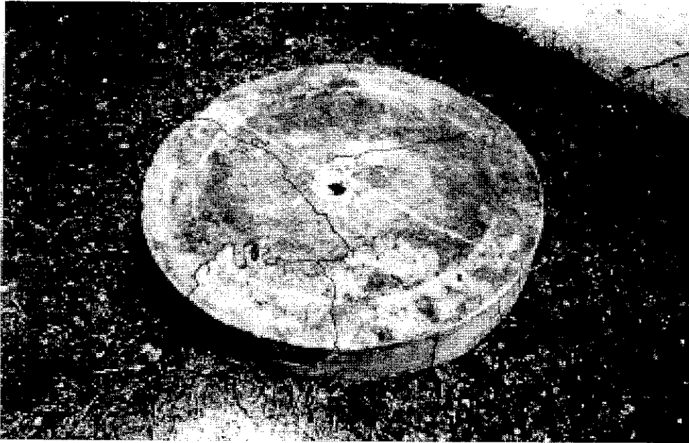
FOTO 3: Muestra las fallas por flexión producidas en las orillas de la tapadera.
