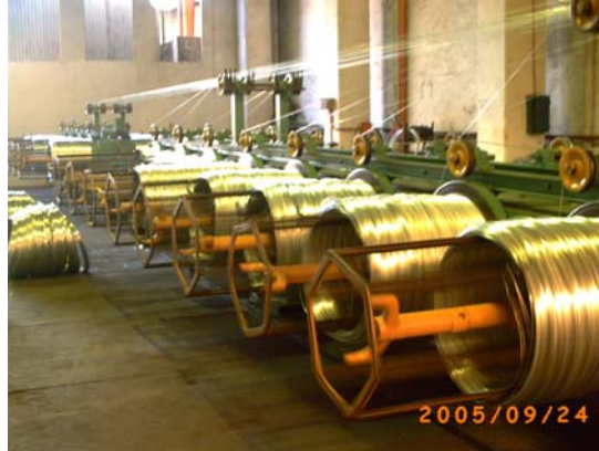
Figura 22. Máquinas embobinadoras en el área de galvanizado
