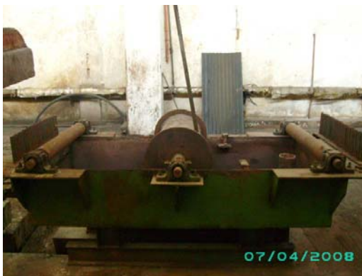
Figura 46. Tanque de enfriamiento
