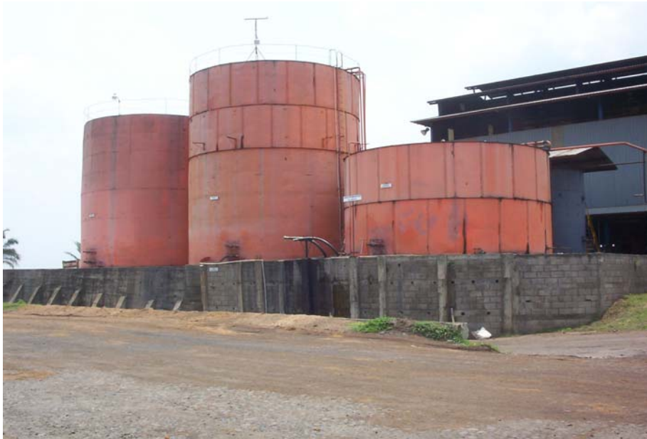
Figura 3. Tanques de producto terminado
