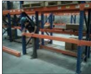
Figura 39. Configuración de la estantería siguiendo el orden estipulado, montaje y desmontaje.
