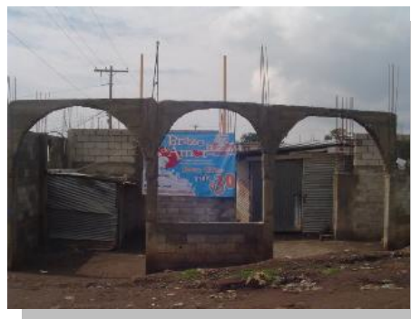
Fuente: Foto Asentamiento La Paz
