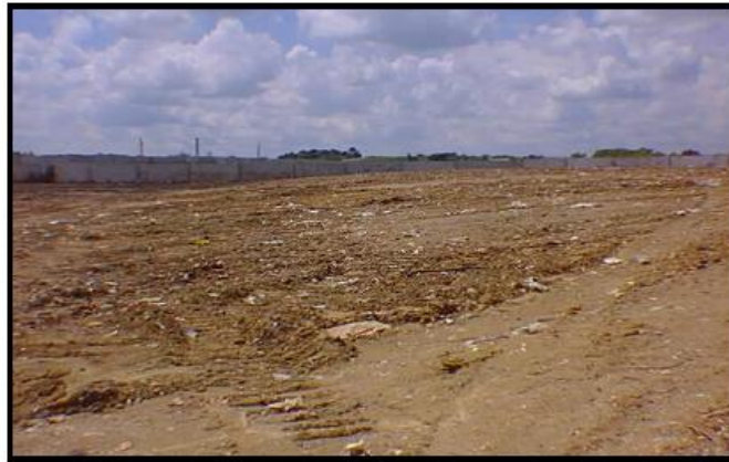
Figura 8. Relleno sanitario en su etapa final
