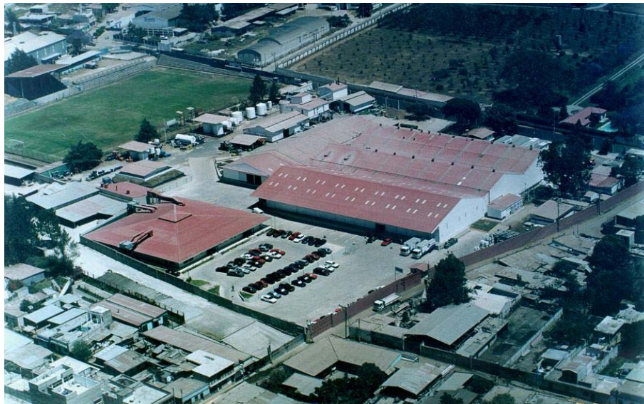
Figura 10. Vista área de fábrica de recubrimientos
