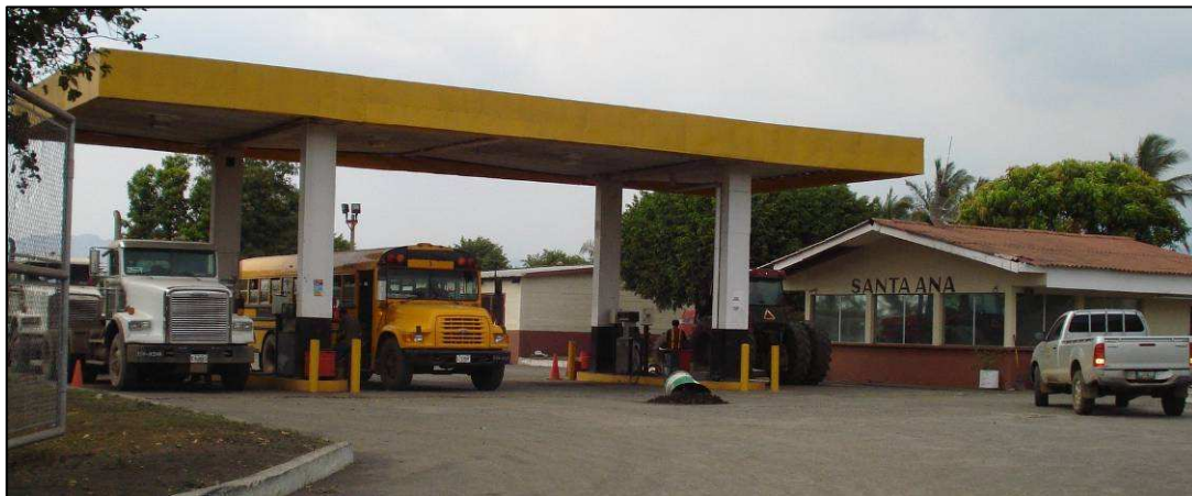
Figura 41. Gasolinera Ingenio Santa Ana
