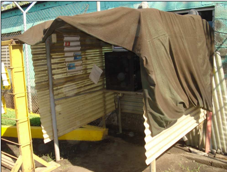
Figura 108. Infraestructura actual del área de lector en el acopio
