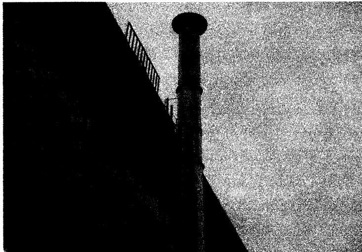
Figura 17. Chimenea de la caldera de granza
