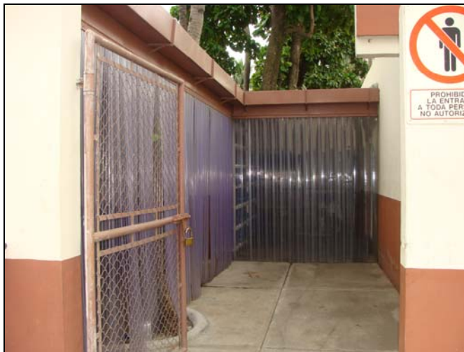
Figura 40. Cortina de aire área de lavado
