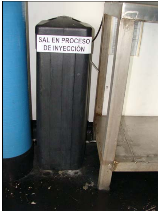
Fuente: Planta de agua purificada
