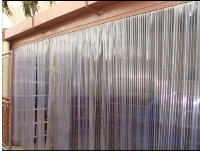
Figura 41. Nuevas instalaciones de la planta de agua purificada
