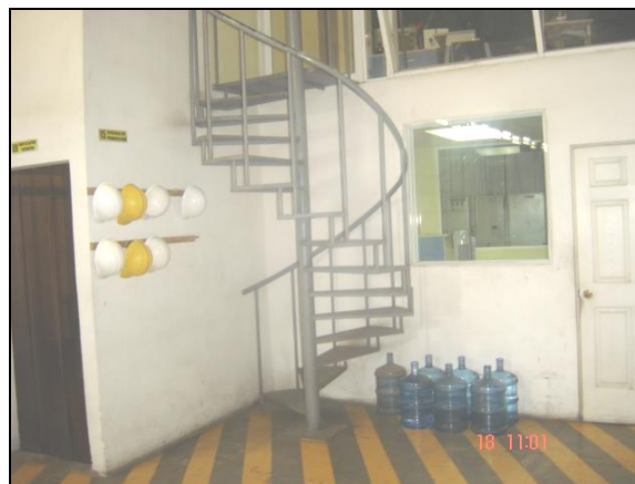
Figura 74. Escaleras dirigidas hacia las oficinas de la planta de producción.
