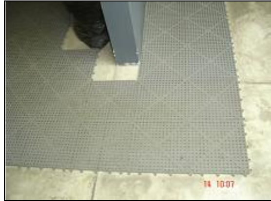
Figura 36. Nueva superficie acondicionada al área de pesaje de vitaminas y minerales en el área de microcomponentes.
