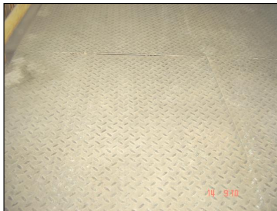
Figura 41. Reparación de la superficie metálica en el área de carga de las líneas de producción.
