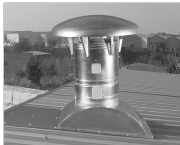
Figura 14. Ventilador tipo hongo
