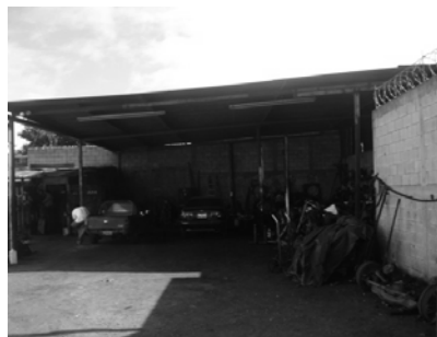
Figura. Ventilación de la empresa
