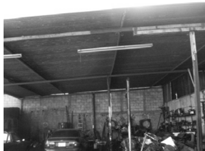
Figura 37. Techo de la empresa
