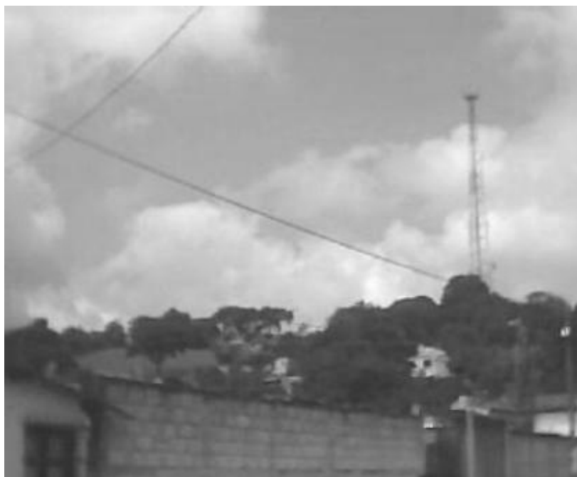
Figura 51. Antena de telefonía celular
