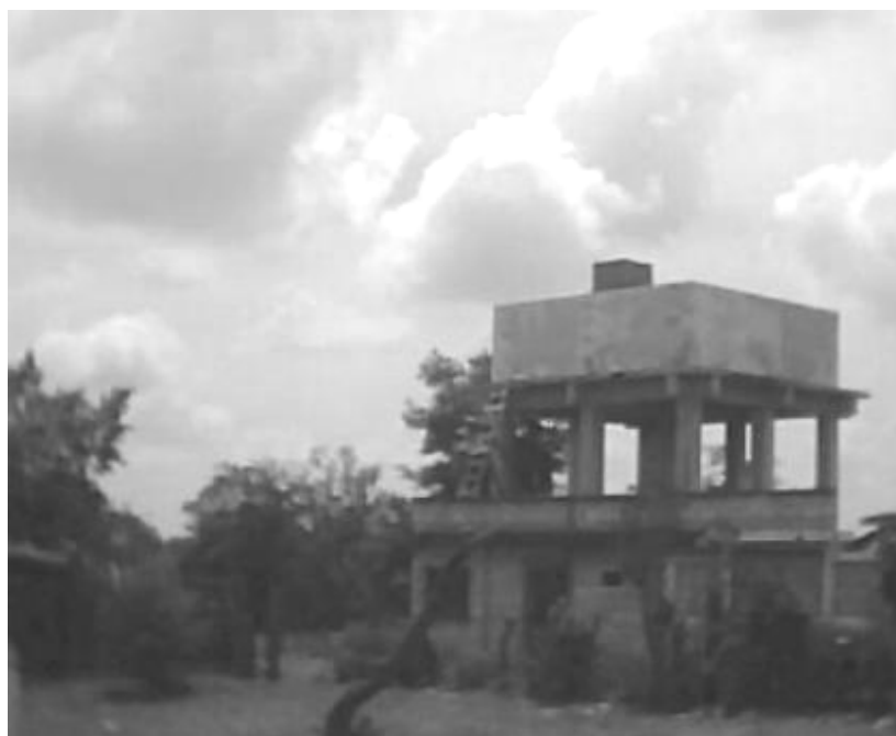
Figura 30. Tanque de distribución de agua potable
