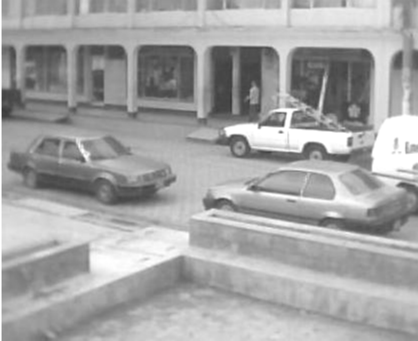
Figura 55. Locales comerciales de la Municipalidad
