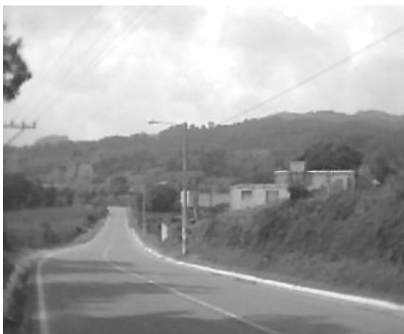
Figura 32. Carretera de acceso a Zaragoza sobre el Km. 63.5 Carretera Interamericana
