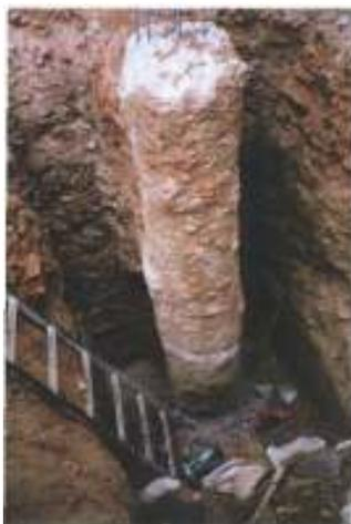
**Figura 18. Defecto detectado mediante el método sónico con martillo de mano**
