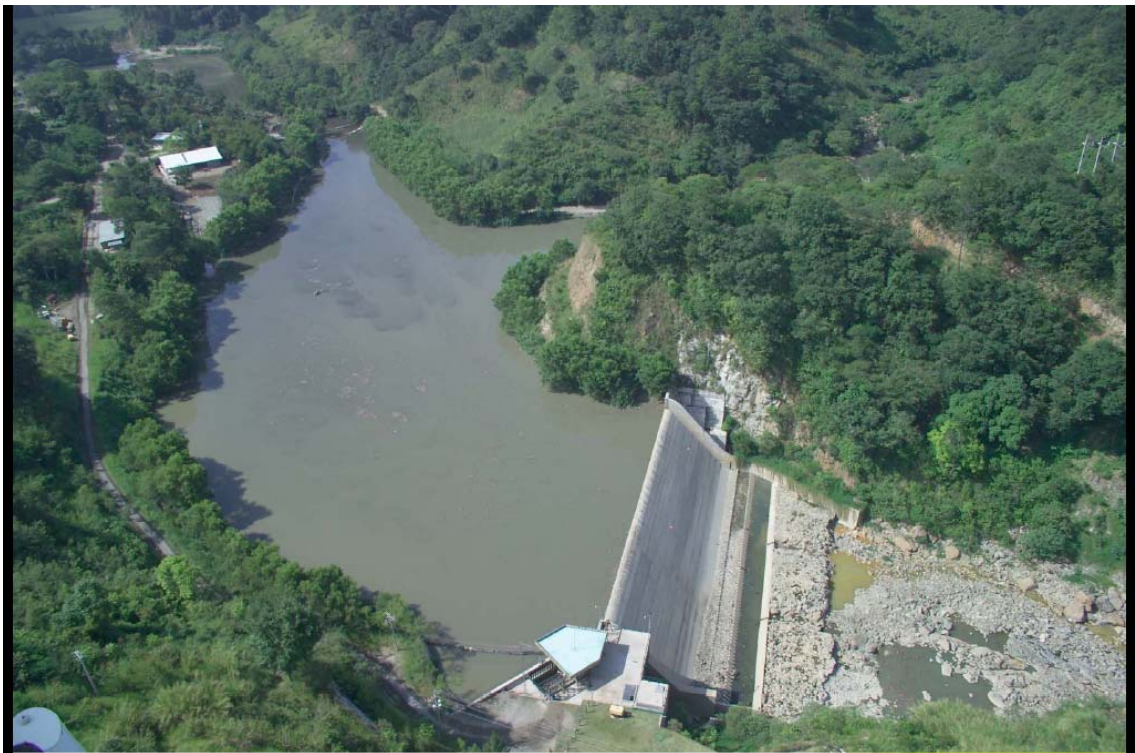
Figura 1. Presa de la Hidroeléctrica río Las Vacas
