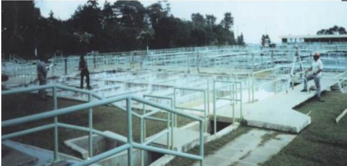
Figura 4. Fotografía del levantamiento topográfico de los floculadores
