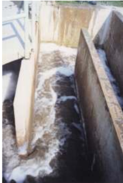
Canales 1 Y 2 del tramo 1
