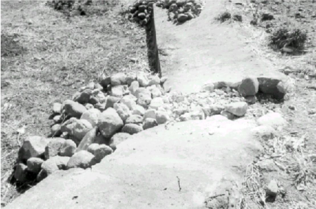
La figura 17, muestra el revestimiento en uno de los taludes de la laguna secundaria, en donde se observa la piedra que se ha desprendido en varios sectores de la laguna y que ha sido apilada en una de las esquinas.
