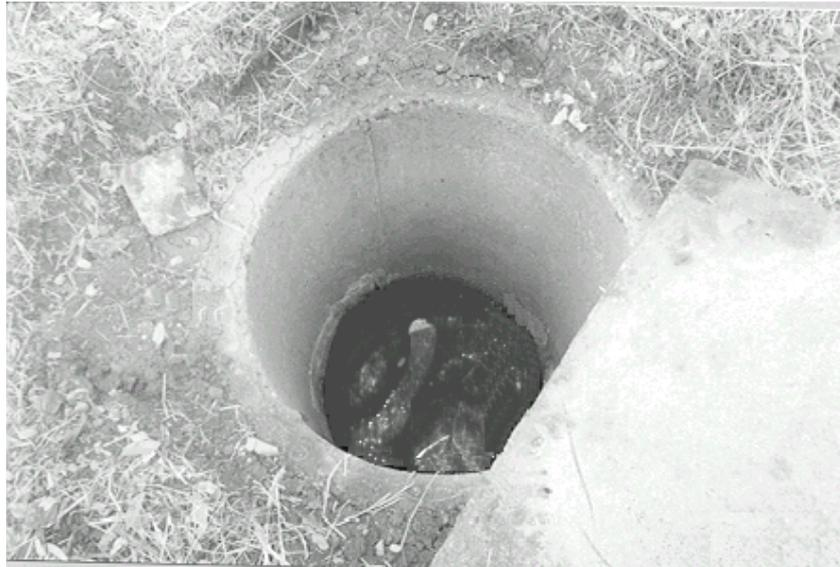
En la caja de registro mostrada en la figura 13, el ingreso del material del suelo más la sedimentación, han provocado la acumulación de lodo en el fondo con la consecuente dificultad en el paso del agua.
