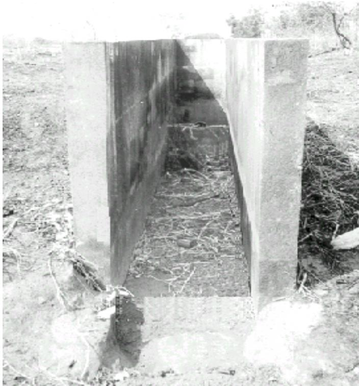
En lo que respecta al estado de la obra civil, las paredes de las estructuras hidráulicas están en buenas condiciones, no así los vertederos de concreto, que necesitan ser reconstruidos (véase figura 20). Además es necesario aplicar un nuevo repello y un alisado interior a la estructura para impermeabilizarla.
