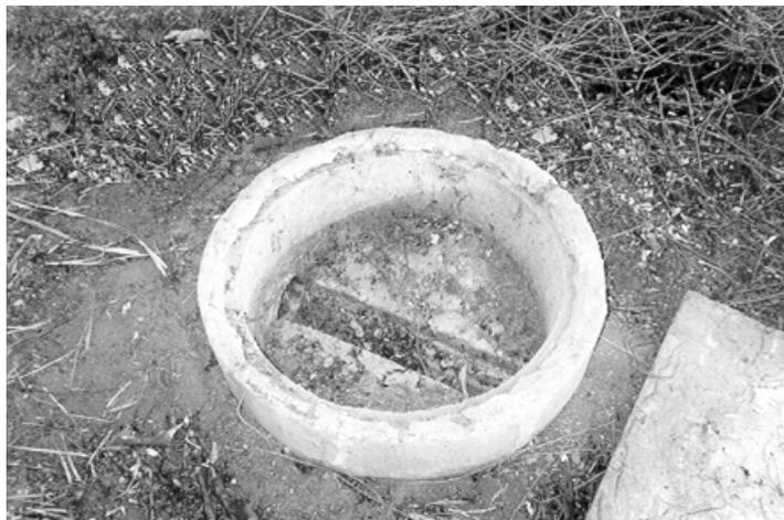
La caja de registro mostrada en la figura 11, no está en funcionamiento porque es una de las estructuras que se localizan posteriormente al desvío de las aguas al quinel, que se describió en la sección 2.3.
