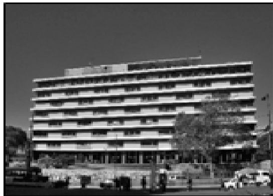
Figura 2: Instalaciones del IGSS
