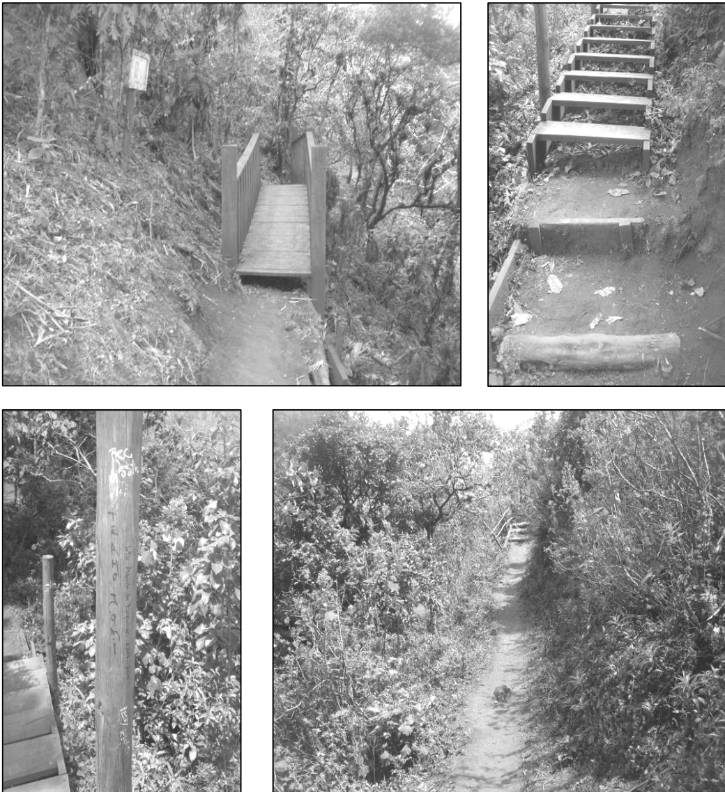
Figura 20. Senderos en mal estado
