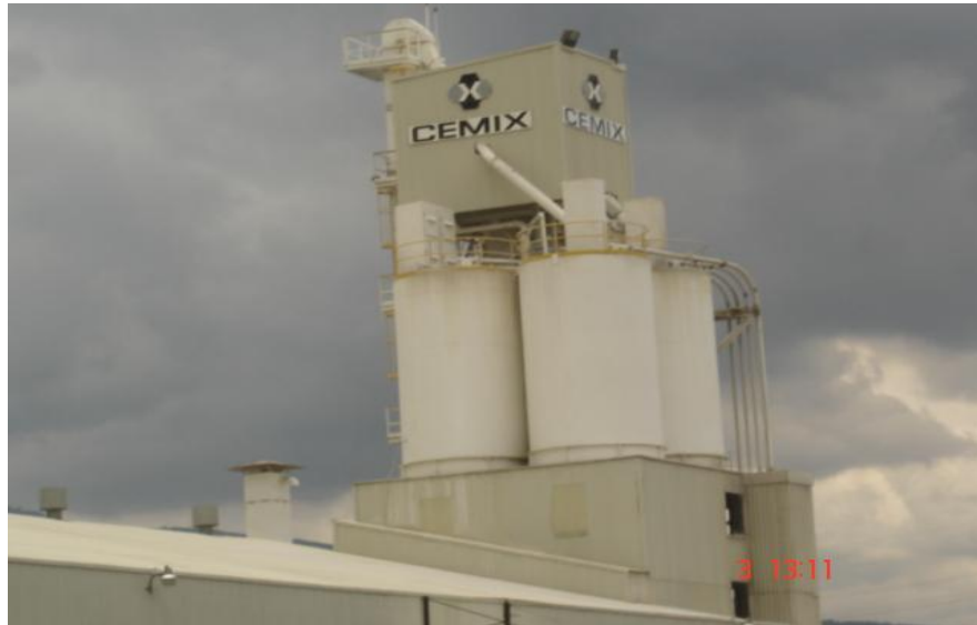
Figura 6. Área de planta torre
