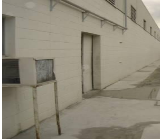
Figura 33. Salida de emergencia de BPT
