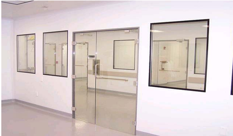
Figura 63. Puertas de vidrio para secciones internas del laboratorio
