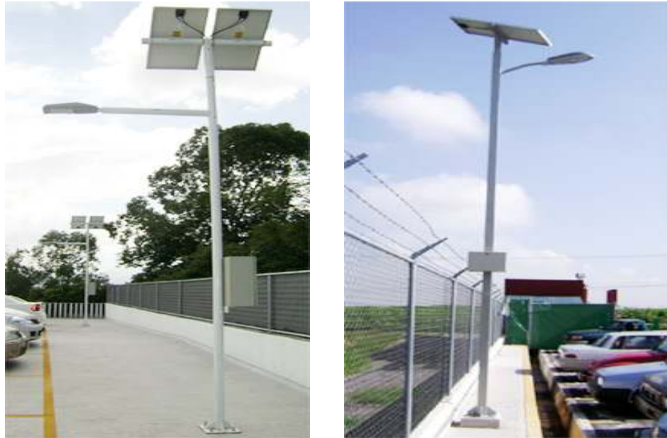
Figura 66. Uso de paneles solares para iluminación de exteriores
