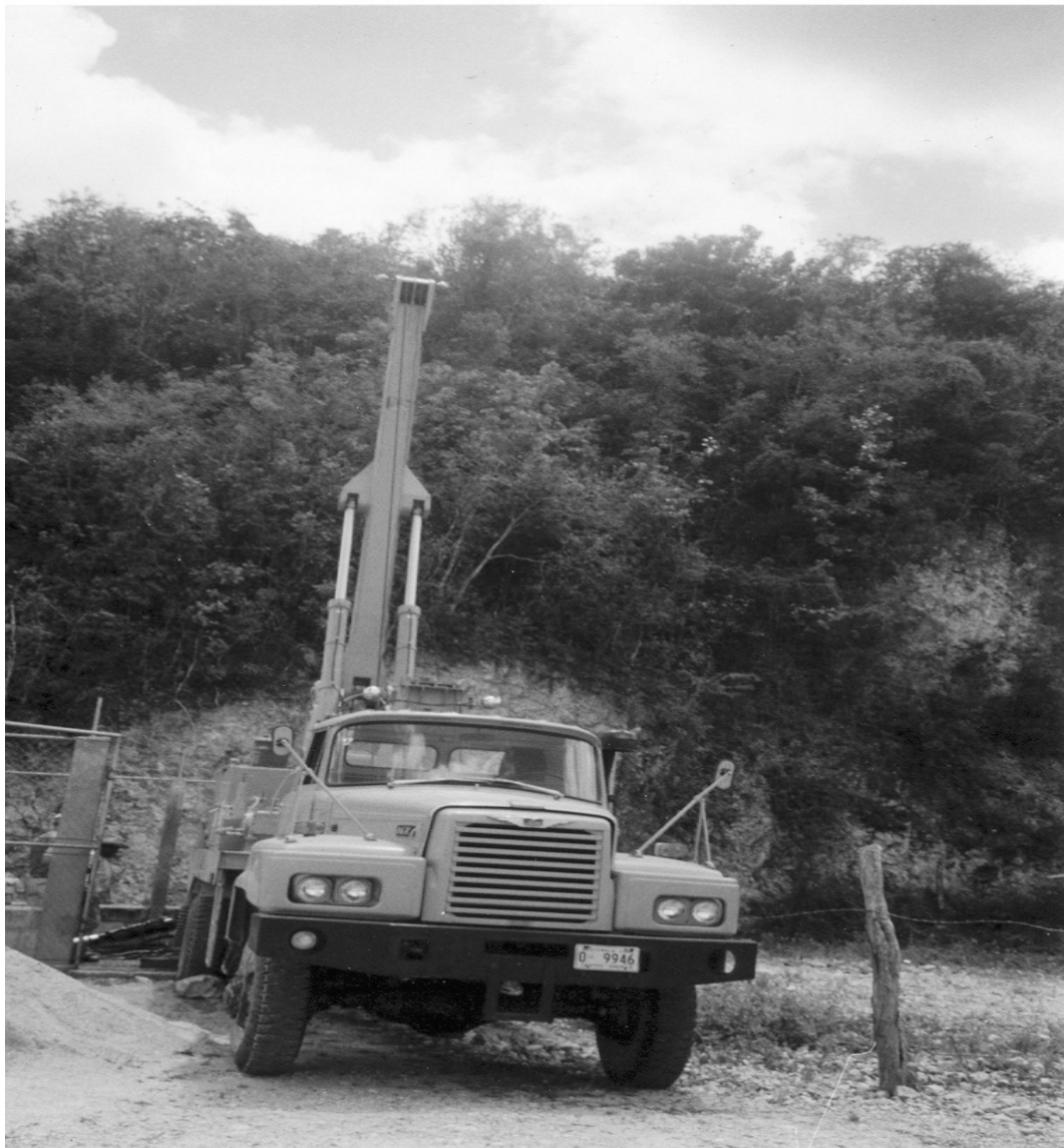
Figura 8. Camión para transportar la grúa hacia el lugar de trabajo
