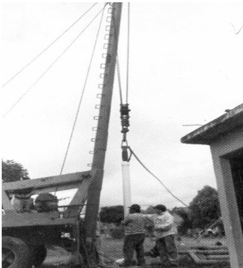
Figura 16. Manejo de equipo para limpieza de pozos en el área de trabajo
