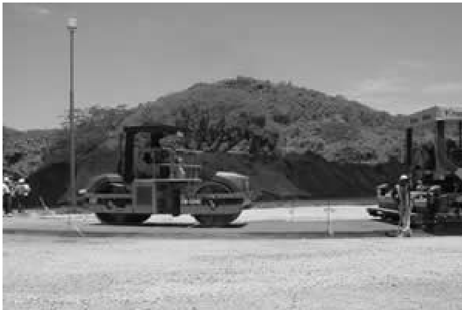
Figura 16. Proceso de compactación usando un rodo doble tipo tándem
