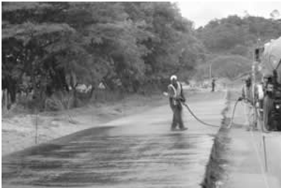
Figura 25. Curado del pavimento de concreto rodillado usando riegos de emulsión
