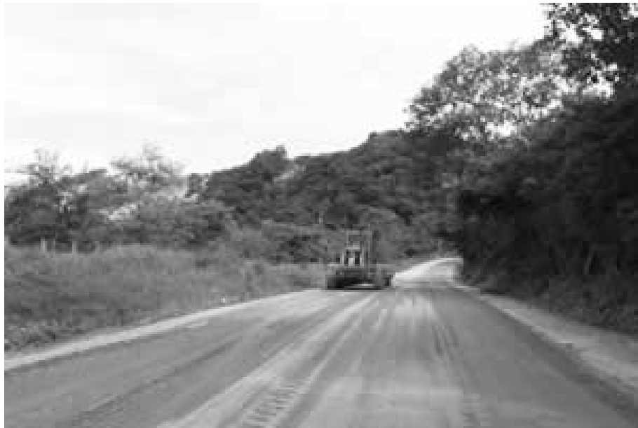
Figura 4. Preparación de la base utilizando moto niveladora
