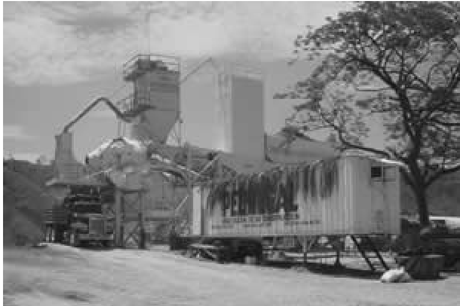
Figura 9. Planta de concreto
