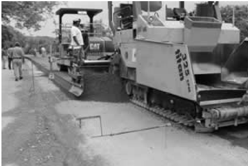
Figura 12. Colocación de la mezcla de concreto usando terminadora
