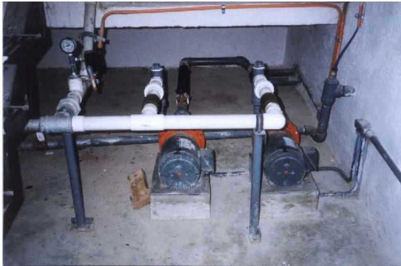
Se deberán utilizar dos bombas funcionando alternamente. La finalidad de tener dos bombas es que en caso que alguna se descomponga, tenemos la otra que funcionará constantemente hasta que se repare la otra bomba. La probabilidad que se descompongan las dos es muy poca, por lo que vale la pena que se disminuya este sistema.
