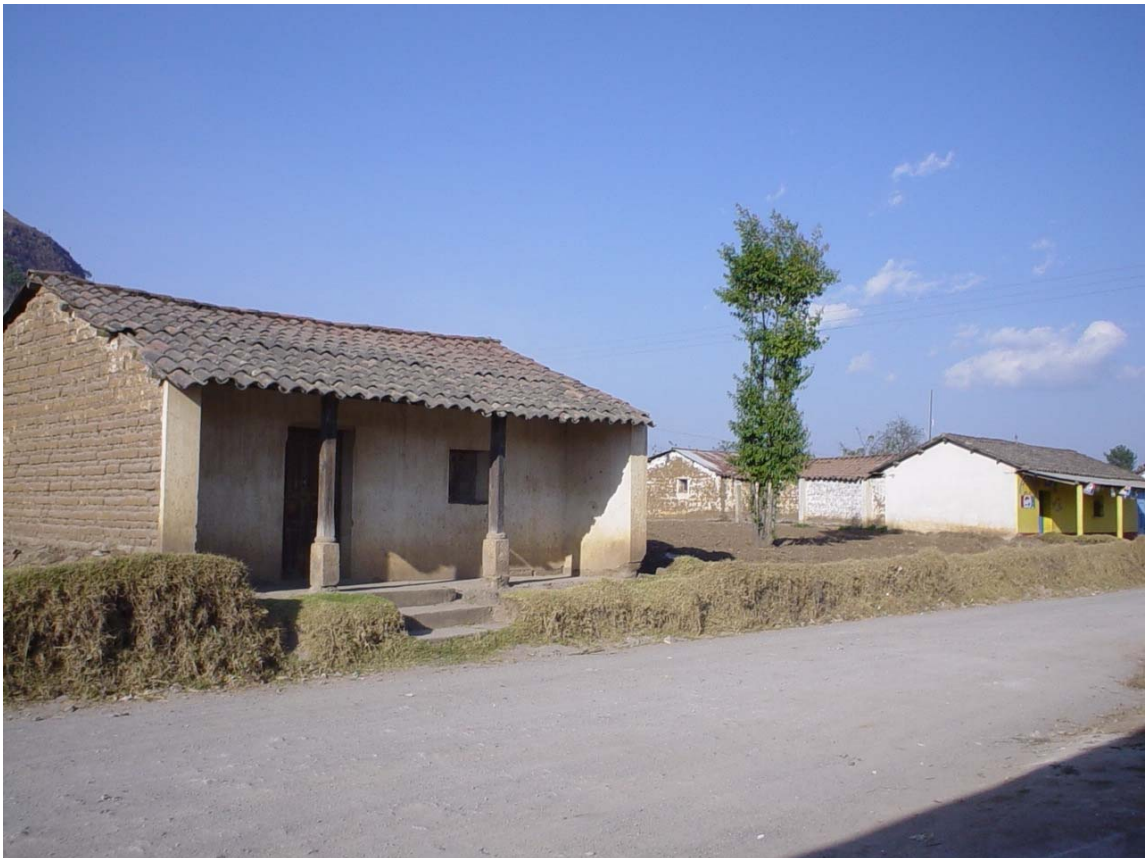
Figura 1. Edificaciones de tierra
