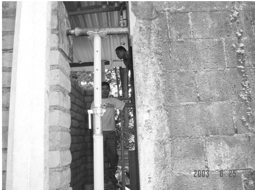
Figura 34. Gatos hidráulicos apoyados en estructura existente
