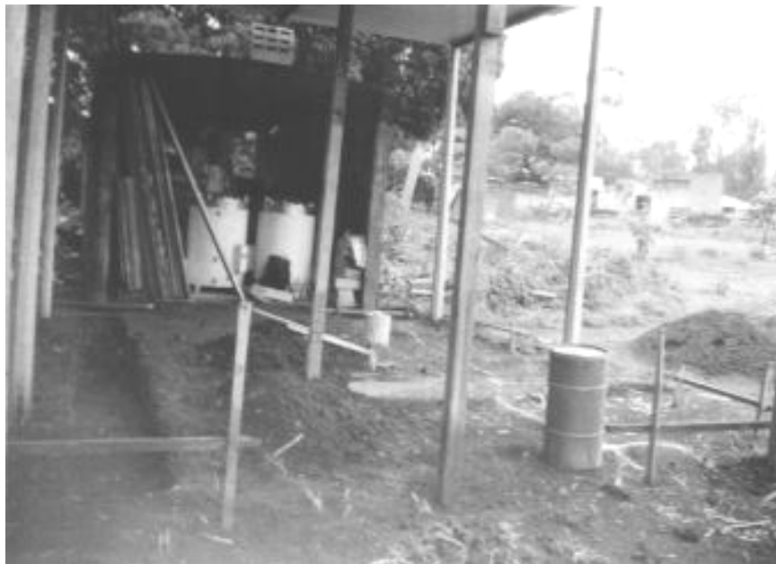
Figura 22. Colocación de puentes y zanjeo, estructura existente al fondo
