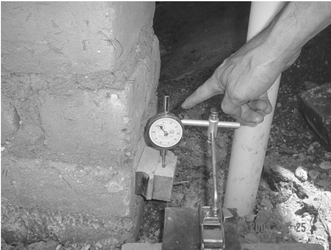
Figura 35. Instalación de deformometro 1 y 2 a 0.25 mts. del nivel de piso
