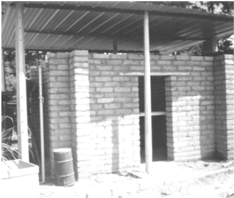
Figura 36. Instalación de tubos para apoyo de los deformómetros 3 y 4 a 2.39 m. del nivel de piso
