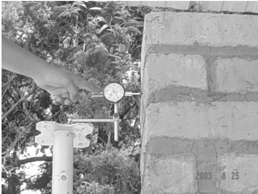
Figura 37. Instalación de deformometro 3 y 4 a 2.39 mts. del nivel de piso
