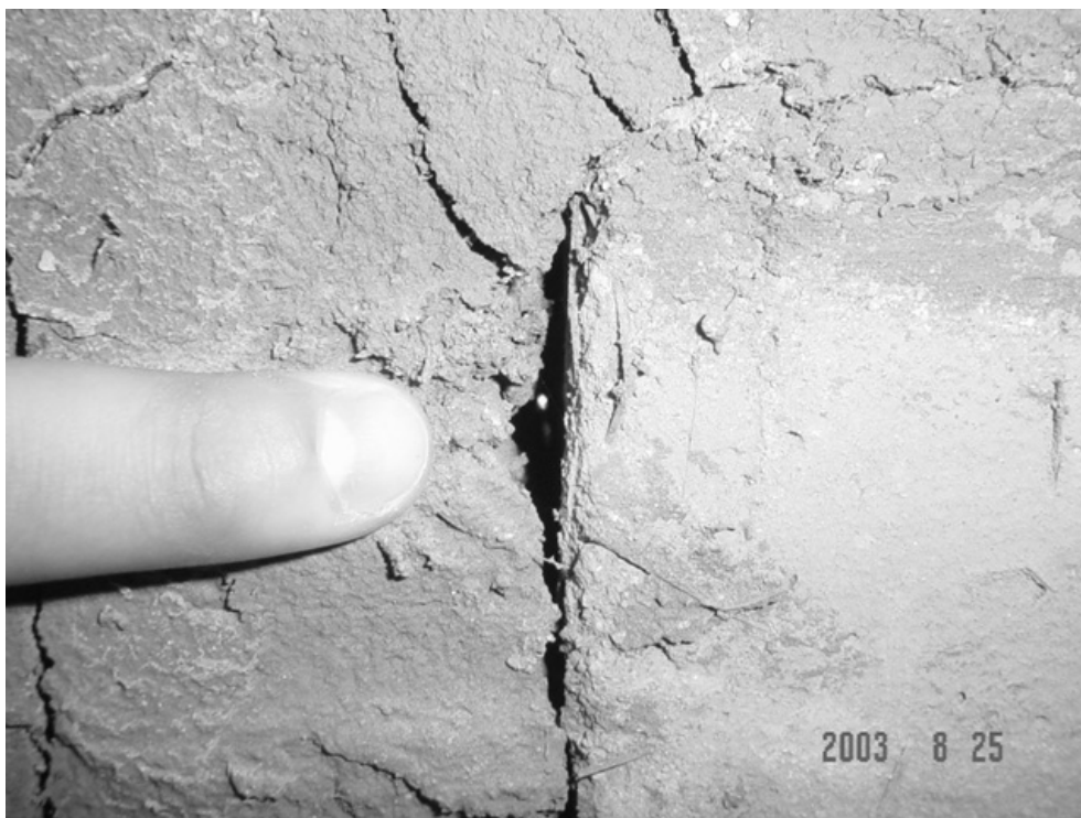
Figura 38. Levantamiento de dintel
