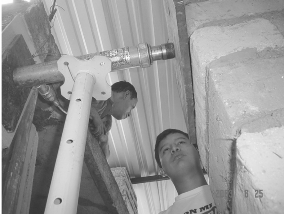
Figura 34. Gatos hidráulicos apoyados en estructura existente
