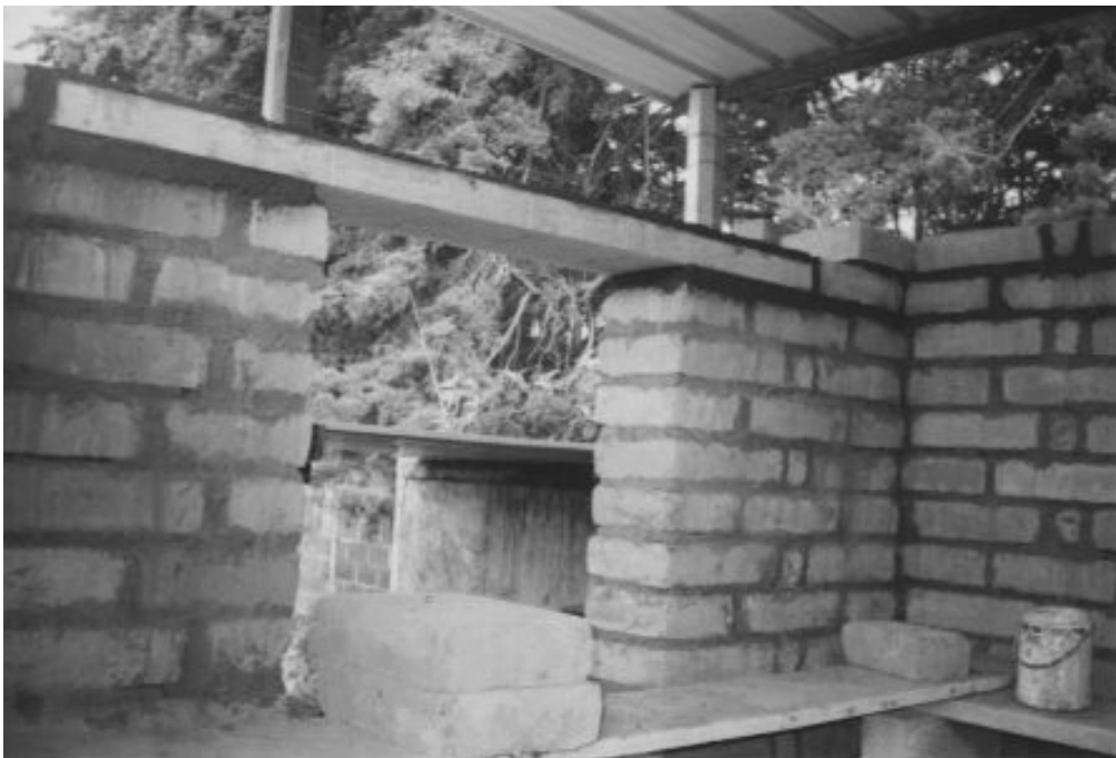
Figura 29. Dintel empotrado en la mampostería de adobe
