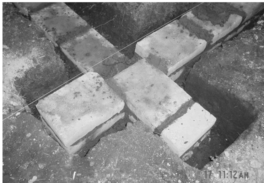
Figura 24. Contrafuertes
