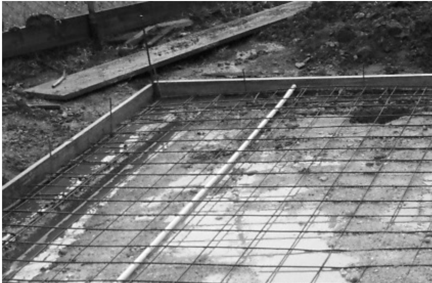
Figura 44. Armado de la losa flotante de cimentación
