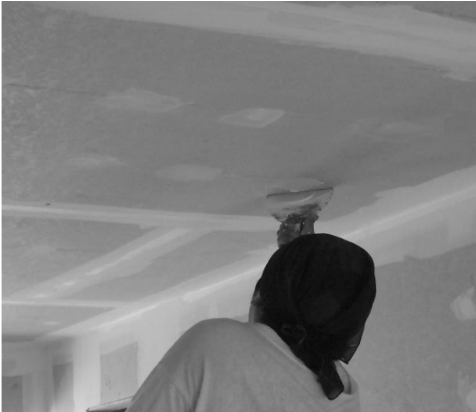
Figura 57. Aplicación de pasta para juntas en las fijaciones
