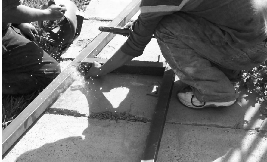
Figura 46. Soldadura en las uniones de los elementos estructurales
