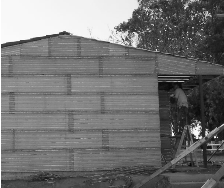
Figura 54. Colocación de malla expandida sobre planchas de fibroyeso
