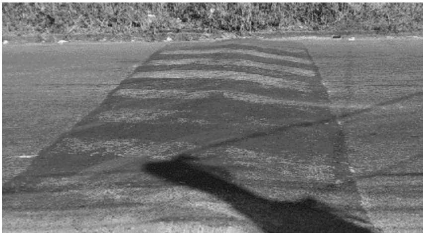
Figura 24. Reductor de velocidad tipo lomo o t́mulo
