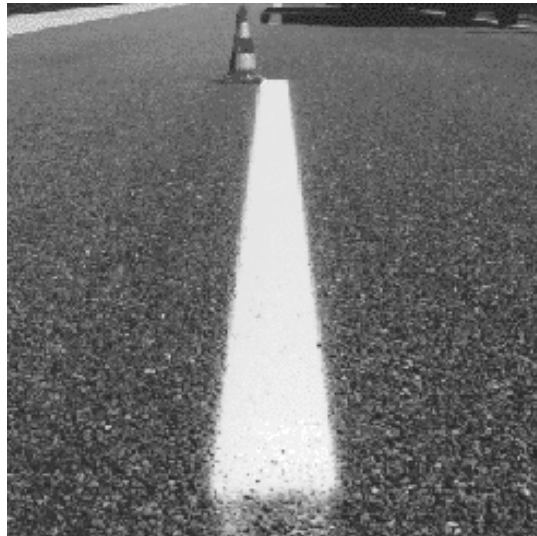
Figura 32. Medidas para evitar el paso sobre pintura fresca
