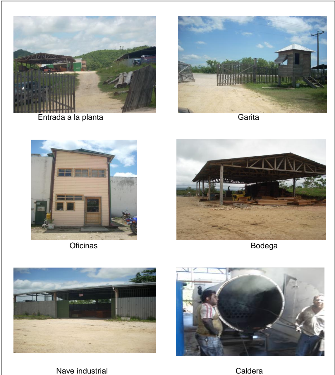
Figura 26. Edificios de la planta industrial
