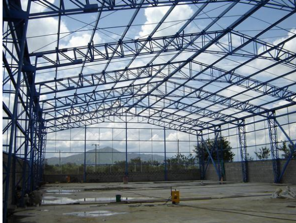
Figura 13. Estructura de Bodega
