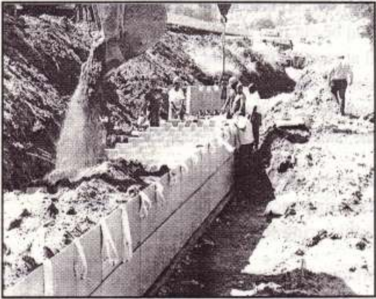
Figura 38. Colocación de relleno seleccionado y compactación atrás de grupo subsecuente
