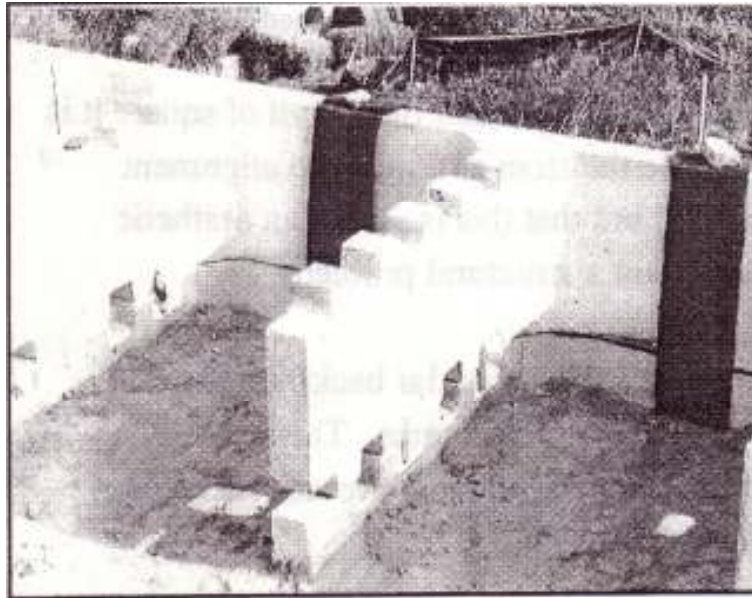
Figura 33. Colocación del filtro de 12" de ancho en las uniones verticales
