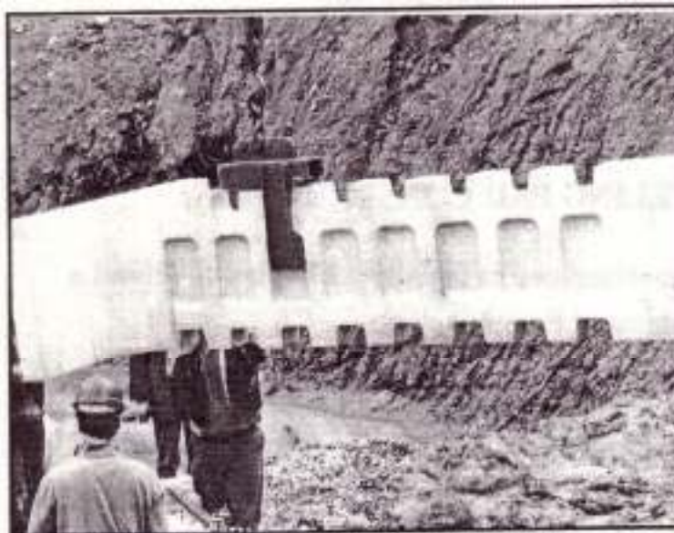
Figura 27. Levantamiento de la unidad t-wall en el punto de balance
