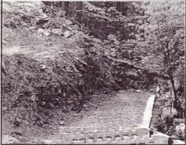
Figura 30. Fundición de la base de nivelación
