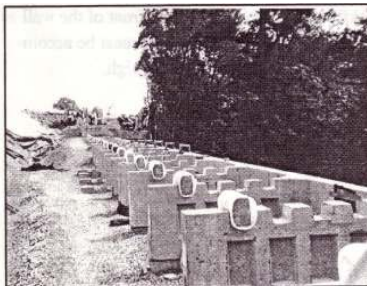
Figura 36. Instalación de las llaves de corte envueltas en 1/4" de material de unión
