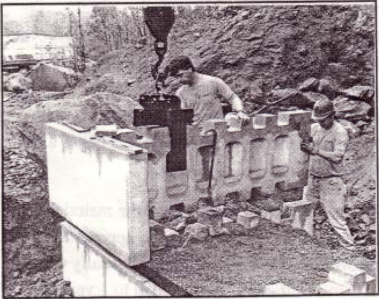
Figura 38. Colocación de relleno seleccionado y compactación atrás de grupo subsecuente
