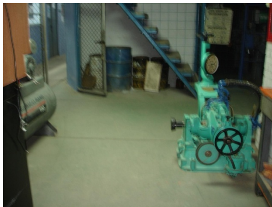
Figura 25. Maquinaria bloqueando pasillo, edificio T-7
