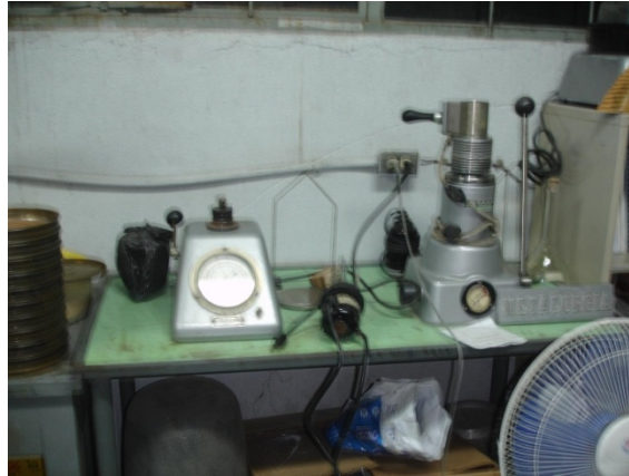
Figura 14. Condiciones actuales de instalaciones eléctricas, edificio T-7
