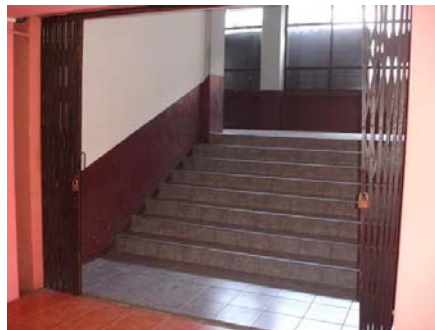
Figura 32. Puerta en el nivel 0, edificio T-3
