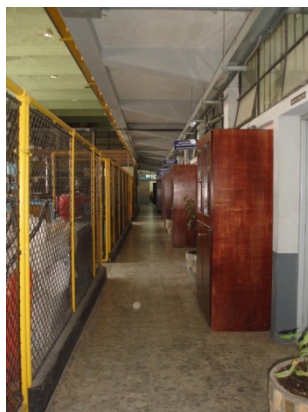
Figura 28. Pasillo Principal, edificio T-5
