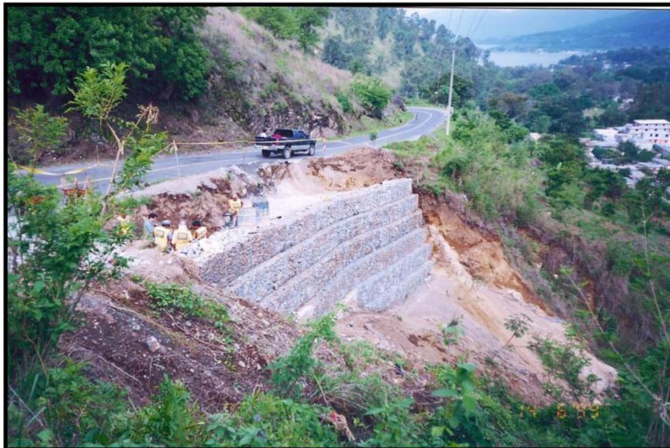
**Figura 47. Utilización de gaviones para la construcción de descargas, Recubierta de capa vegetal, sin alteraciones al medio ambiente, San Rafael, pie de la Cuenca, San Marcos**
