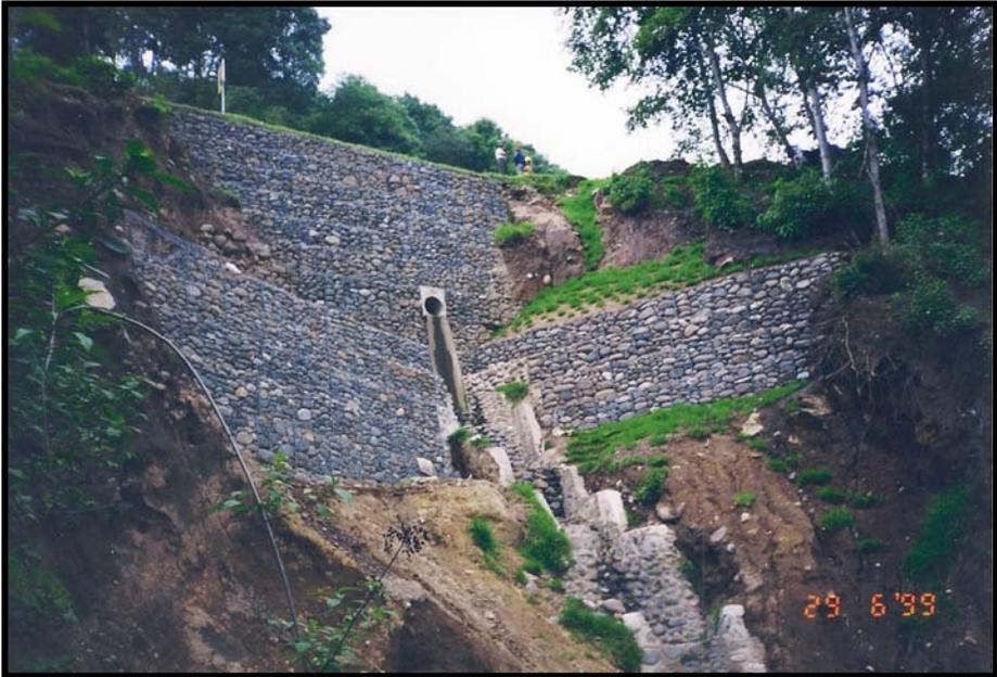
**Figura 44. Estabilización de talud con gaviones y grama, San Marcos**
